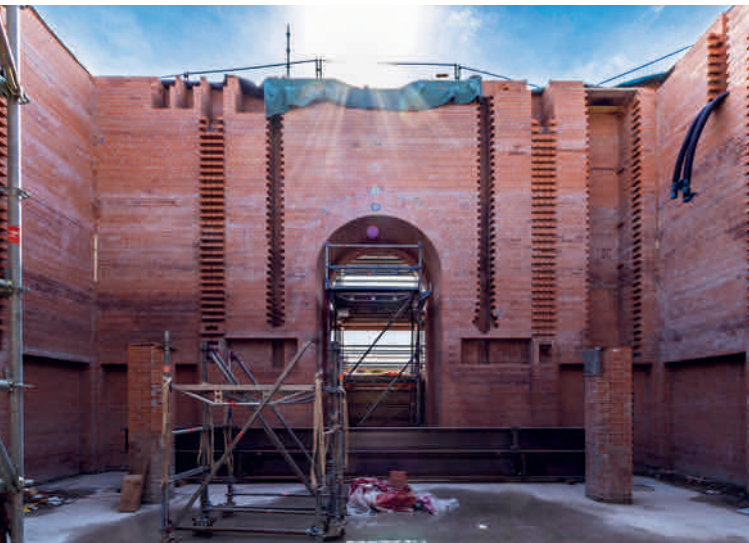
Die Kapelle im Turm im Rohbau. Foto: Dr. Peter Michael Bauers
