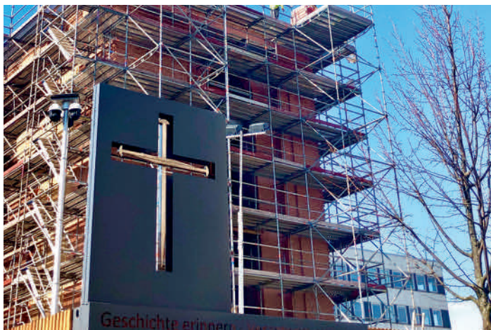
Die Baustelle des Garnisonkirchturmes. Foto: Dr. Stephanie Hochberg
